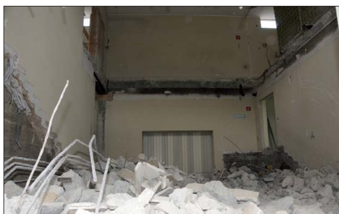
Stiegenhaus im Norden
