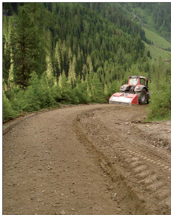
Die Fräse der Fa. Holzer bei der Arbeit
