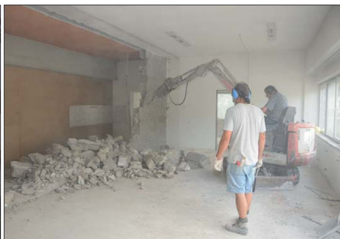
Abbrucharbeiten im Inneren des Gebäudes (ehemalige Hauptkanzlei)
