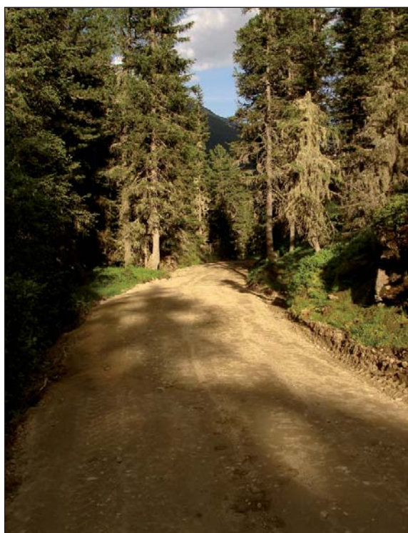
So sieht die Fahrbahn nach erfolgter Sanierung aus.
