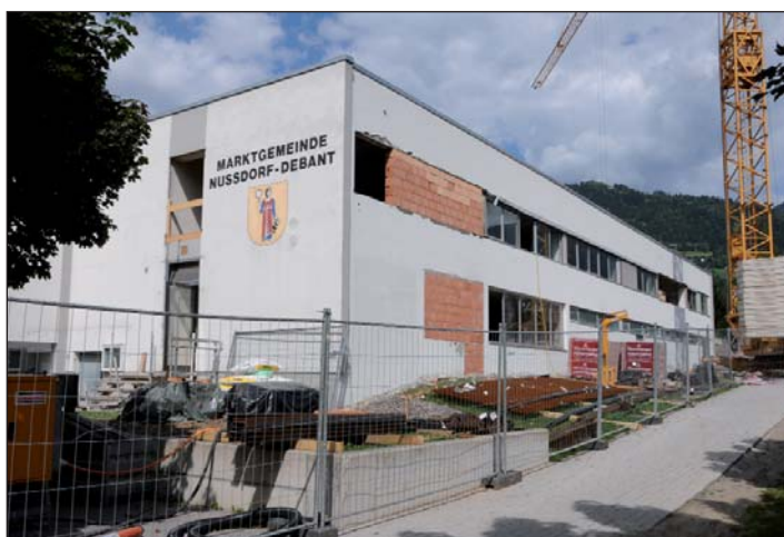
Teile der neuen Südfassade
