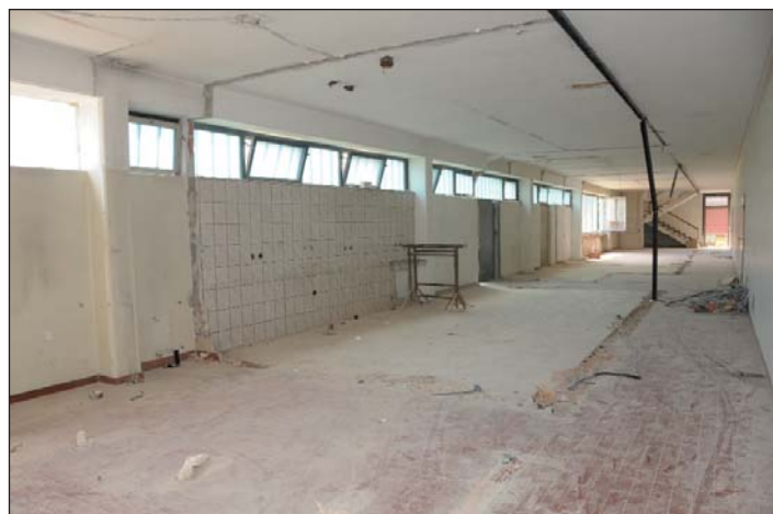
Alle Zwischenwände im Erdgeschoss (Süd) wurden entfernt.
