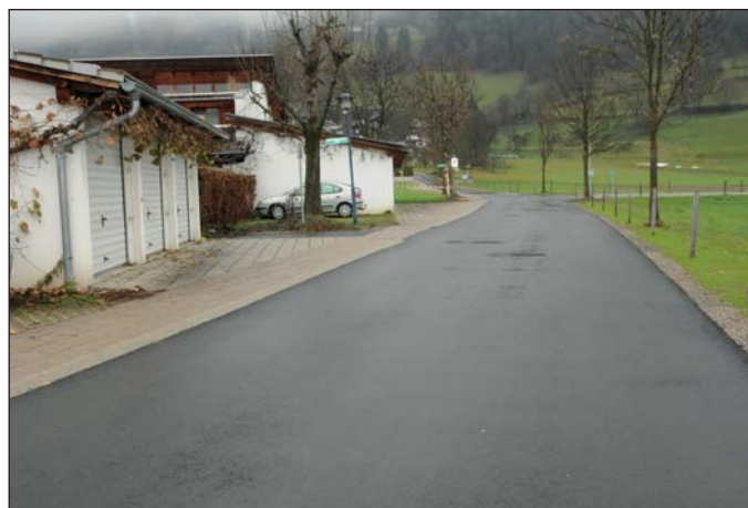
Ein Teil der Dolomitenstraße wurde heuer generalsaniert.
