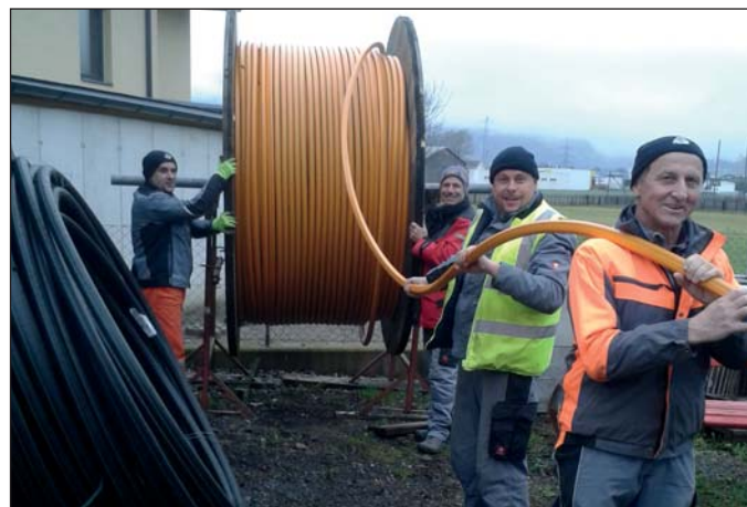
Der Bauhof verlegte heuer die ersten Glasfaserkabel.
