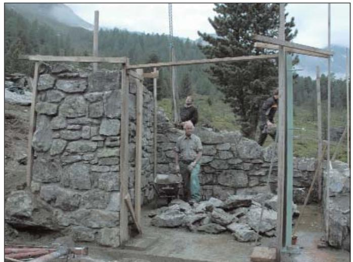
Die Grundmauern für die neue Hofalm-Kapelle werden als rustikales Bruchsteinmauerwerk ausgeführt.
