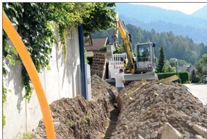
Die Firma Porr beim Verlegen von LWL-Leerrohren in Nußdorf
