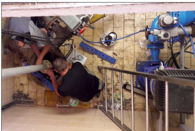
Pumpentausch im Tiefbrunnenhaus
