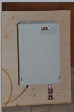
LWL-Hausanschlussbox, wie sie in den Wohnhäusern installiert wird
