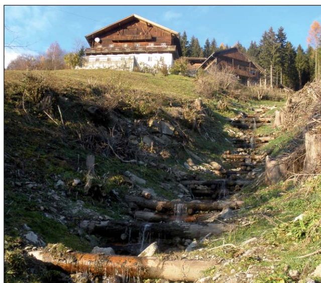
Dorfbach unterhalb der Hofstelle Bödenler in Obenußdorf nach Sicherung mit Holzquerwerken bzw. Steinkästen
