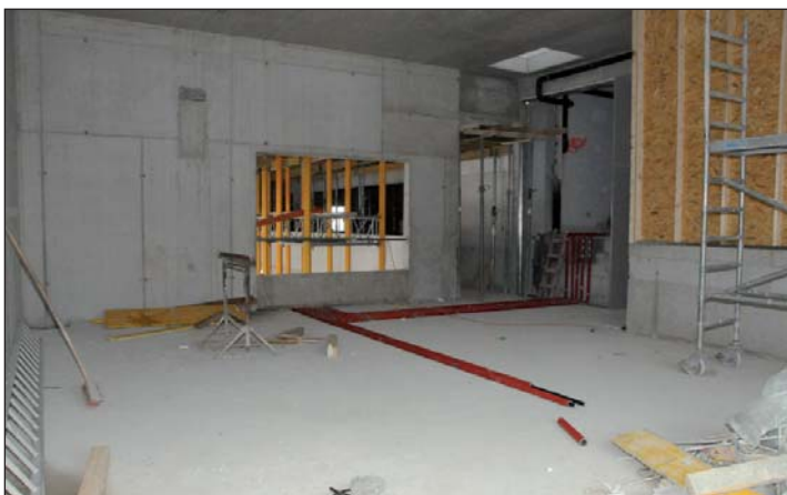
Hier entsteht die neue Gemeindebücherei.
