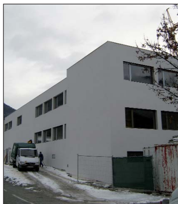
Die ersten Teile der Fassade sind bereits fertig.
