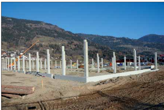
Das Grundgerüst des neuen Fachmarktzentrums war noch vor Wintereinbruch fertig.
