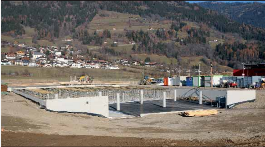
Die Tiefgarage soll noch heuer fertiggestellt werden.
