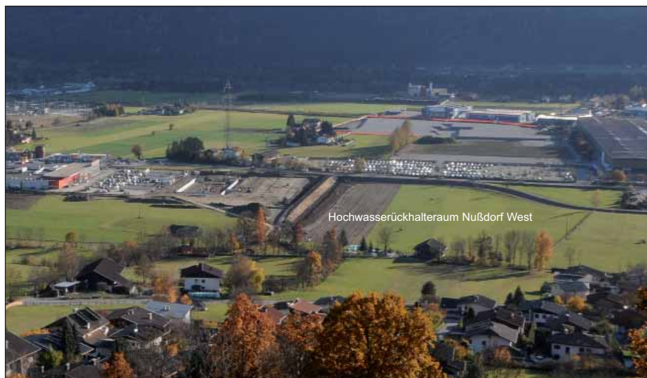
Die Dämme des Wasserrückhalterums Nußdorf West kurz vor der Fertigstellung
