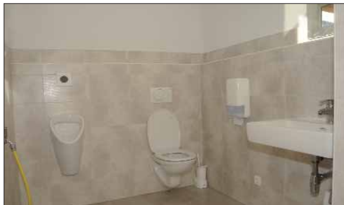
Das behindertengerechte WC von innen
