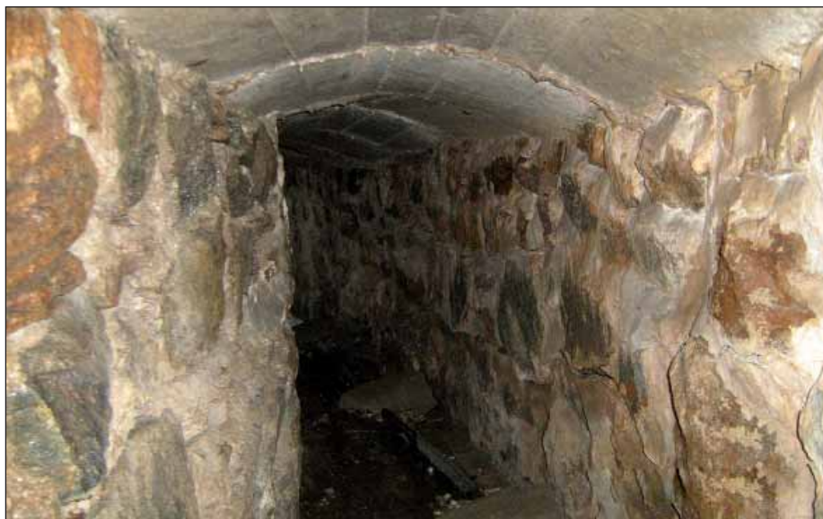
Die tunnelförmige Quellfassung der Tocknig-Quelle
