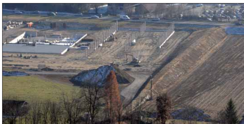
Blick auf den neu geschütteten Damm westlich der Fachmarktzentrumsbaustelle; auch der Zufahrtsweg Richtung Nußdorf wurde verlegt und ist im Rohzustand bereits wieder erkennbar.
