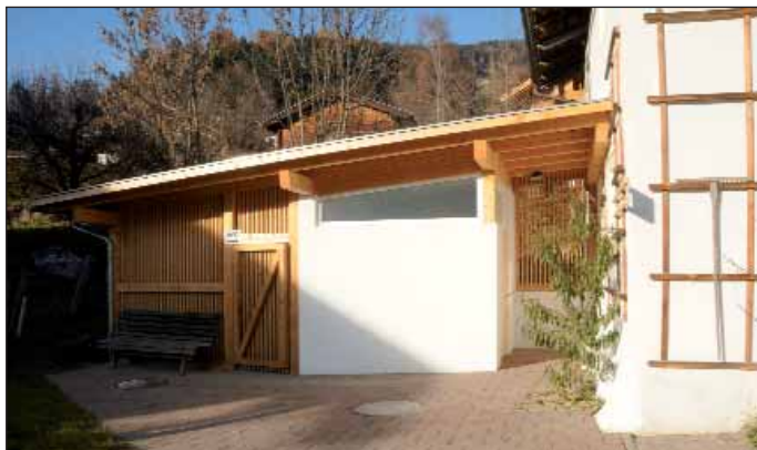
Der schlichte Zubau für das öffentliche WC und das Holzlager
