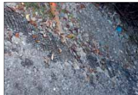
Der Weg wurde in diesem Abschnitt mittels Geogittern neu aufgebaut und drainiert.
