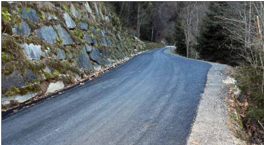
Sanierter Abschnitt zwischen den Wainig-Bachln
