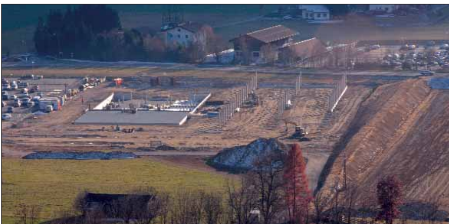
Übersicht über die Fachmarktzentrumsbaustelle (rechts davon ein Teil des Wasserrückhaltedamms)
