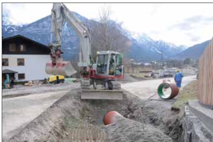
Der neu verrohrte Dorfbach beim Abele
