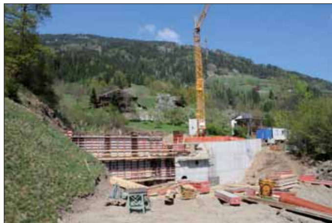
Blick auf das neue Dorfbach-Auffangbecken beim Nußbaumerhof
