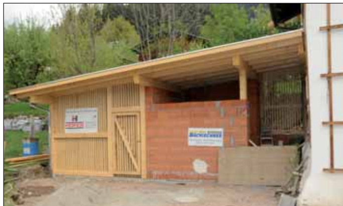
Das im Bau befindliche öffentliche WC in Nußdorf
