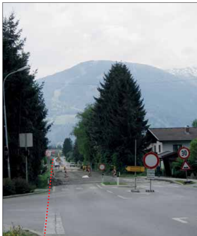
Die Glocknerstraße ist in den nächsten Monaten eine Großbaustelle. Im Bereich der roten Markierung entsteht der neue Gehsteig.
