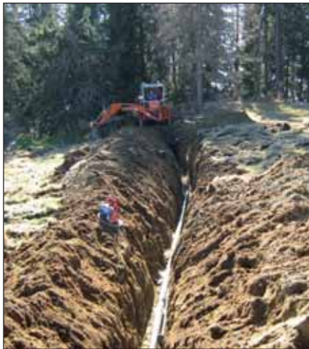
Unser Bauhof beim Verlegen der neuen Hydrantenleitung
