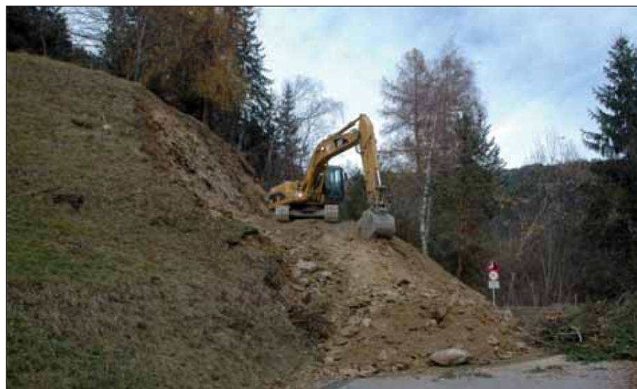
Spektakuläre Bauarbeiten am Debanttalweg
