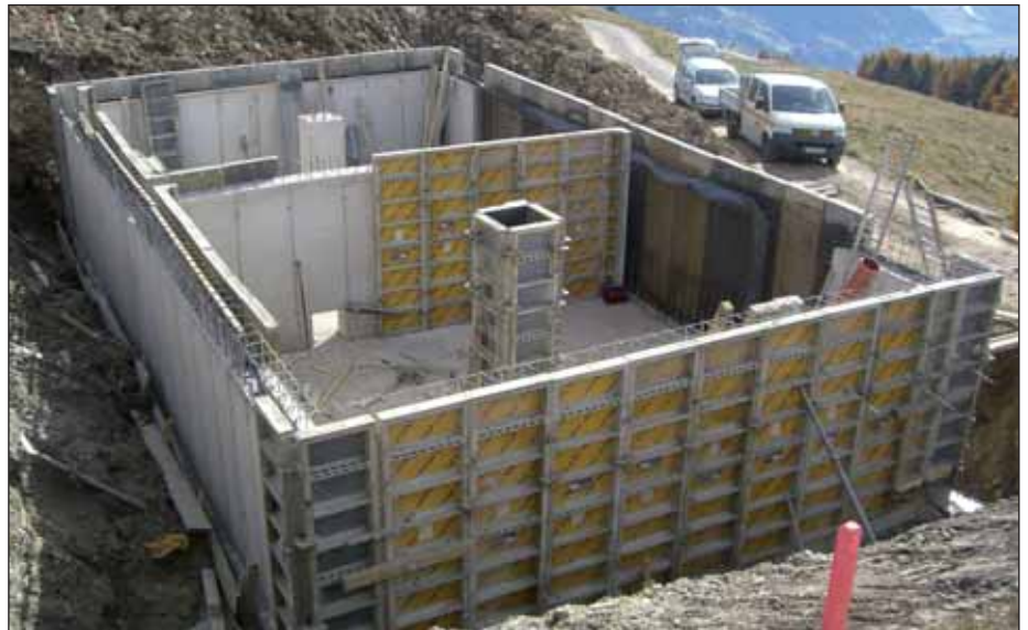
Der neue Löschwasserbehälter im Rohbau
