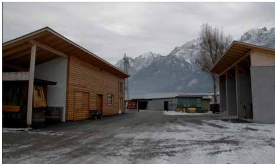
Unser neues Bauhofsplittlager (r.) mit dem befestigten Vorplatz
