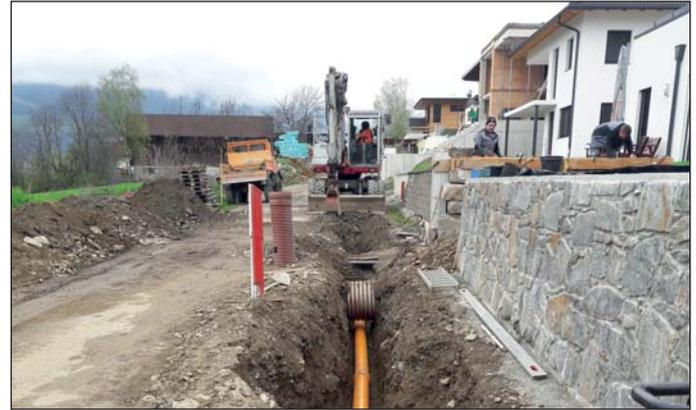
Zur Verbesserung der Trinkwasserqualität im Bereich Sonnenhang und Dolomitenblick wurde im heurigen Frühjahr eine „Ringleitung“ hergestellt. Damit ist in Zukunft eine dauernde Wasserzirkulation sichergestellt.
