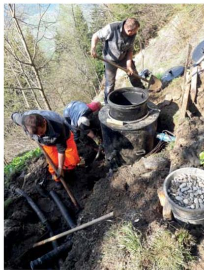
Sanierung der **Webhofer-Quelle** am Hochberg nach einem Rohrbruch
