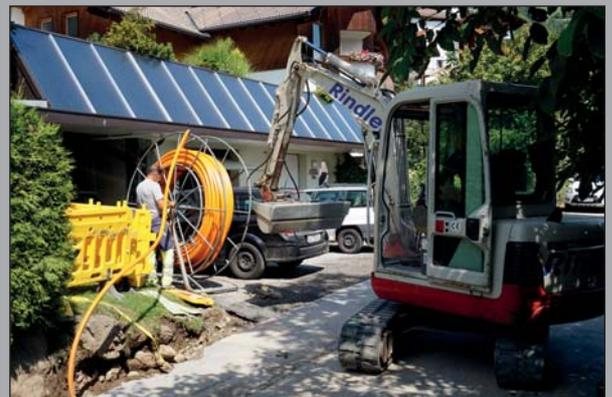
In einem dritten Schritt wurden bzw. werden von diesen Verteilerkästen **bis an die Grundstücksgrenzen aller Wohn- und Betriebsgebäude Leerrohre** mit 0,7 bzw. 1,0 cm Durchmesser (= Speedpipes) verlegt, die von den jeweiligen Eigentümern bis in ihre Gebäude weitergeführt werden können.
