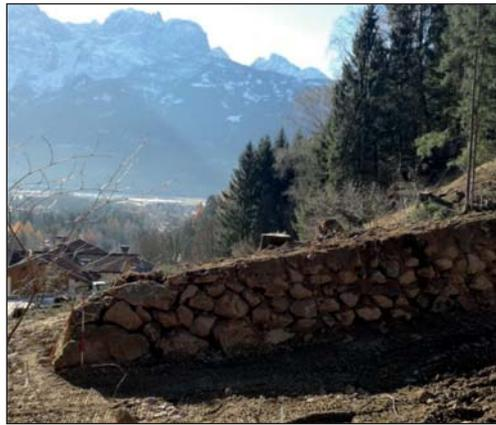
Die Wildbach- und Lawinerverbauung hat Ende November mit dem Bau eines neuen steinvermauerten Schutzdammes am Innig-Bachl begonnen. Dieser soll verhindern, dass bei einem Hochwasserereignis die Wohnhäuser Groger, Kranebitter/Peuckert, Gumpitsch und Wallensteiner überflutet werden. Die Fertigstellung ist für das kommende Frühjahr vorgesehen.
