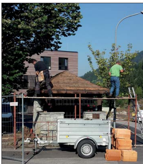
Eindecken der Dachschindeln
