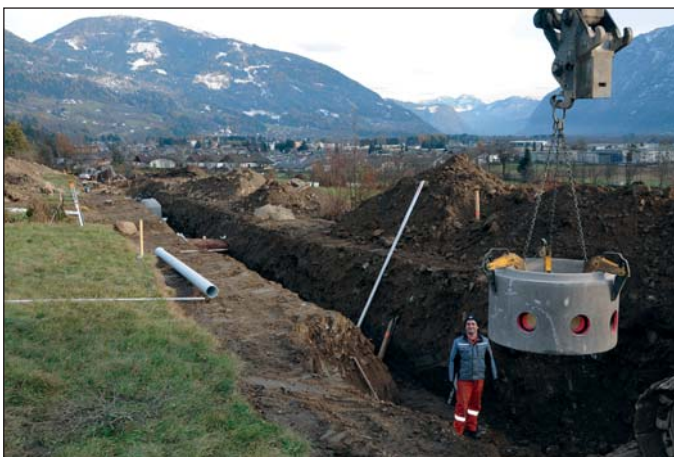
Unsere Bauhofmitarbeiter beim Verlegen des Kanals am Sonnenhang
