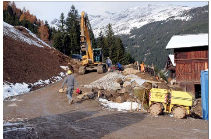
Die Baustelle bei der Hofzufahrt Leitner kurz vor der Fertigstellung
