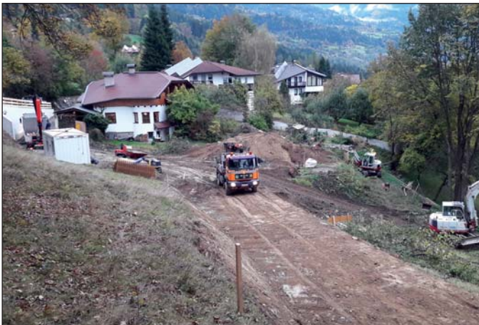
Der neue Stichweg am Mellitzweg im Rohbauzustand
