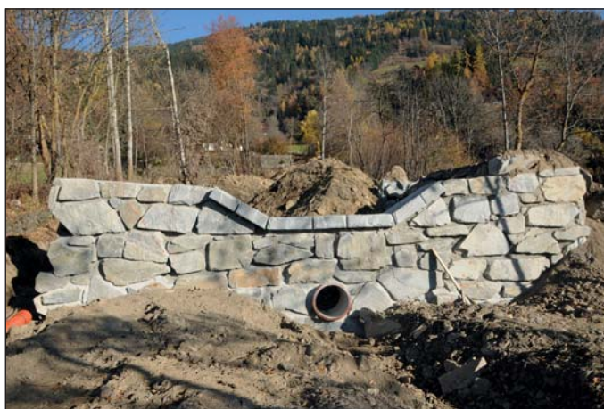
Die neue Sperre am Zwieslingbach
