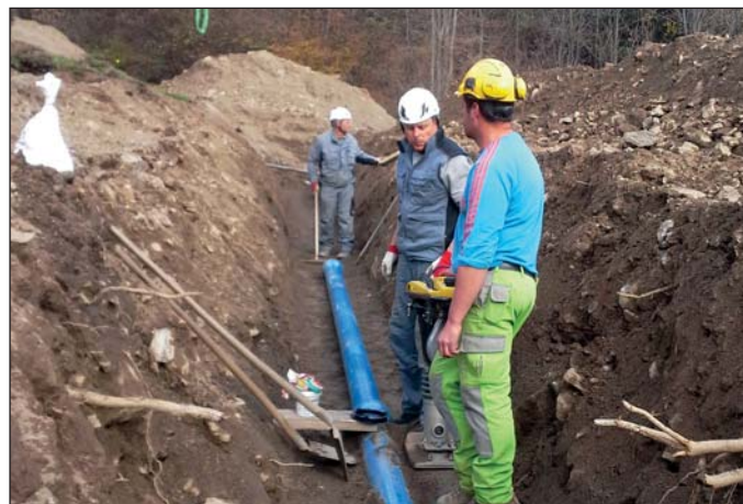
Unsere Bauhofmitarbeiter beim Verlegen der neuen Pumpleitung
