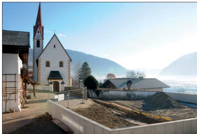
Hier entsteht der „neue Nußdorfer Friedhof“.
