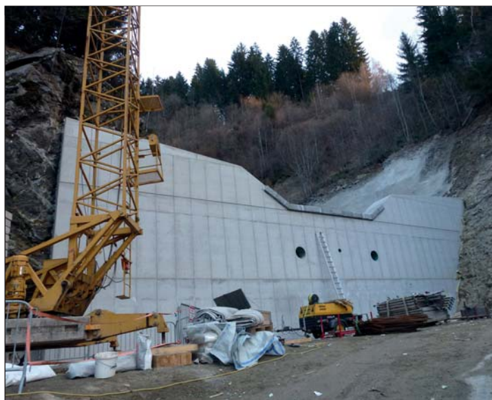
Konsolidierungssperre am Wartschenbach, vor Fertigstellung 2015
