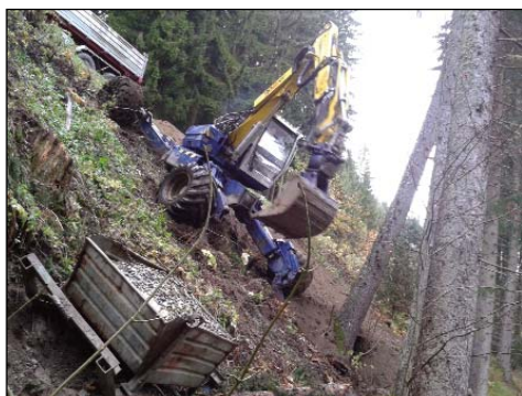
Quellfassung im extremen Gelände
