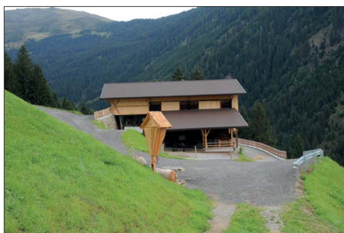
Das Wirtschaftsgebäude Leitner mit dem neuen Zufahrtsweg
