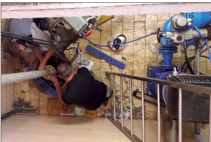
Pumpentausch im Tiefbrunnenhaus
