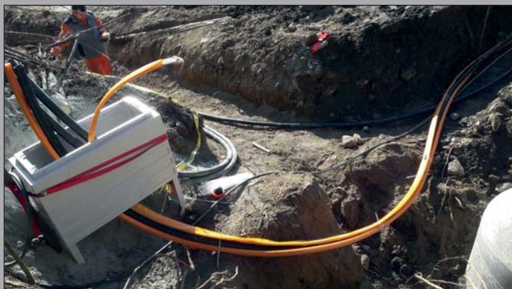
Auch unser Bauhof ist mit dem Verlegen von LWL-Leerrohren beschäftigt.
