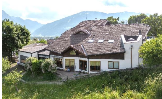
Ansicht Ost – Altbau (mit Zubau links im Bild)
