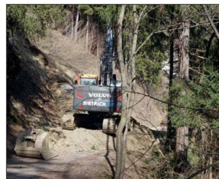
Steinschlichtungsarbeiten im Bereich eines Murenabganges am Perlogerweg
