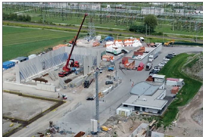
Die ersten Hallen am Rossbacher-Areal sind im Entstehen.
