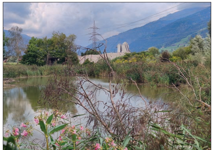
BNW-Teich in Debant mit der derzeitigen Stromleitung nach Kärnten
