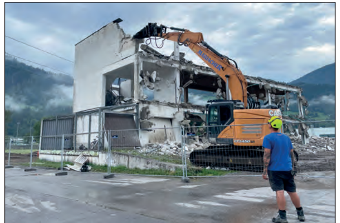
Abbrucharbeiten beim ehemaligen Möbelhof Agunt
