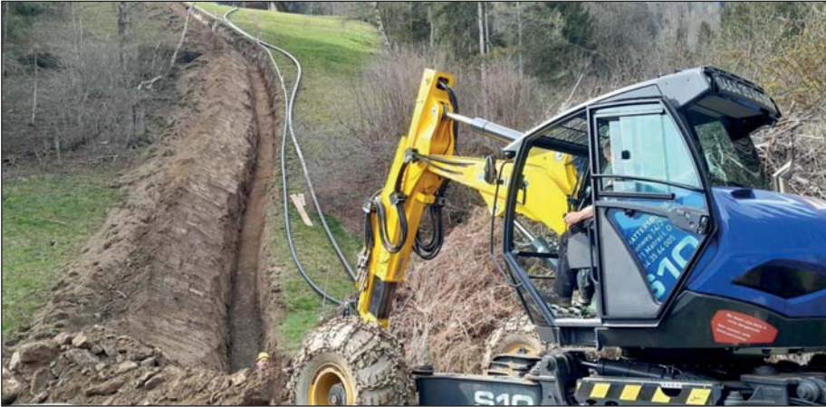
Beginn der Kanaltrasse Richtung Innig im Talbereich
