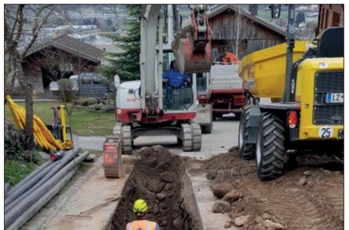
Wasserleitungsarbeiten am Mellitzweg
