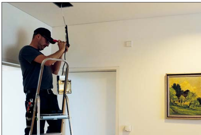
Hausmeister Michael Ebner beim Lampentausch im Bürgermeisterbüro
