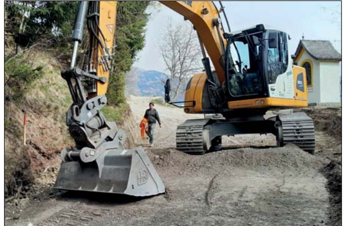
Generalsanierungsarbeiten am Basisweg im Bereich Marienstöckl
