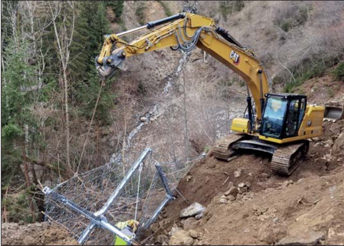
Anlegung einer neuen Zufahrt zur Sperren-Baustelle
