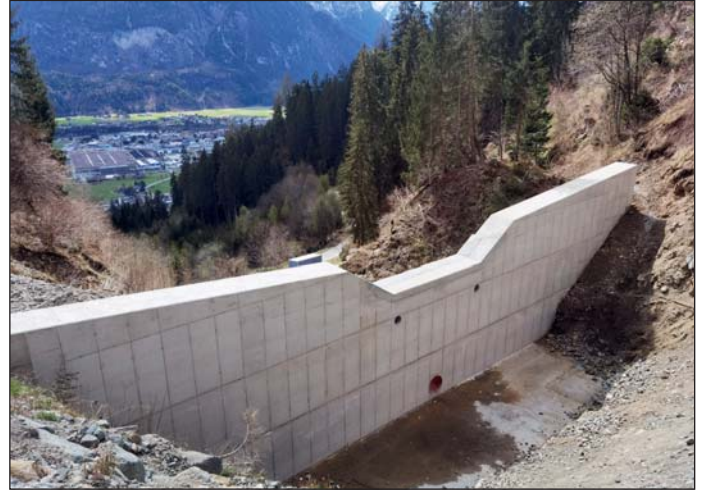
Die neue Sperrenstaffel kurz nach der Fertigstellung
