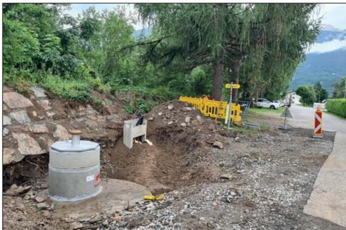
Für die neue Trinkwasserleitung Richtung Debanttal wurde eine Druckerhöhungsanlage installiert.
