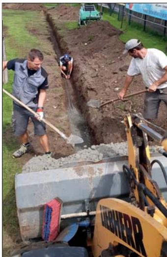
Verlegung der Strom- und Steuerungsleitungen für die neue Flutlichtanlage
