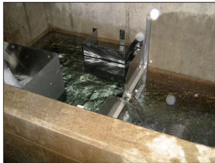
„Treffpunkt“ unserer 10 eingespeisten Quellen - der Quellsammelschacht in Nußdorf
