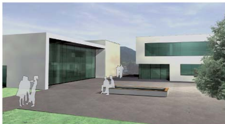
Gemeinde- und Kulturzentrum Nussdorf-Debant _ Umbau, Zubau und Neubau Entwurf sowie Realisierung von Schneider&Lengauer Architekten
