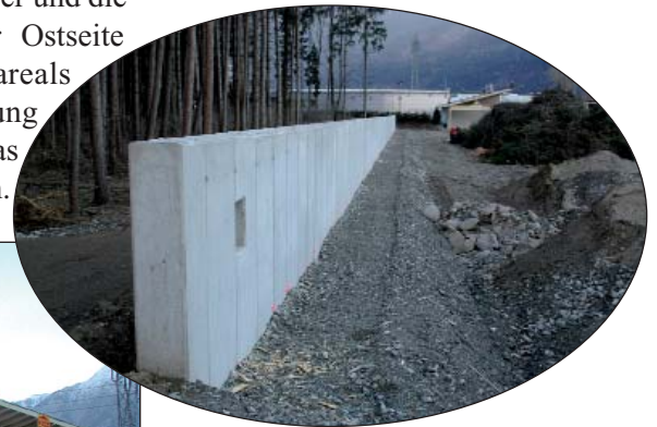
Eine 85 m lange Prallwand grenzt das Außenlager vom Pappelgarten ab
