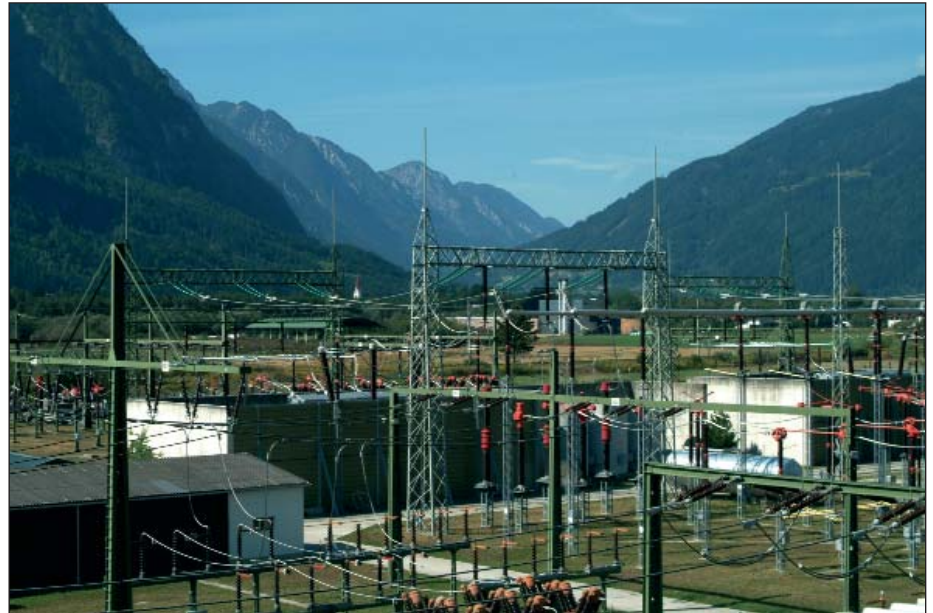
Transformatoren des Umspannwerks
