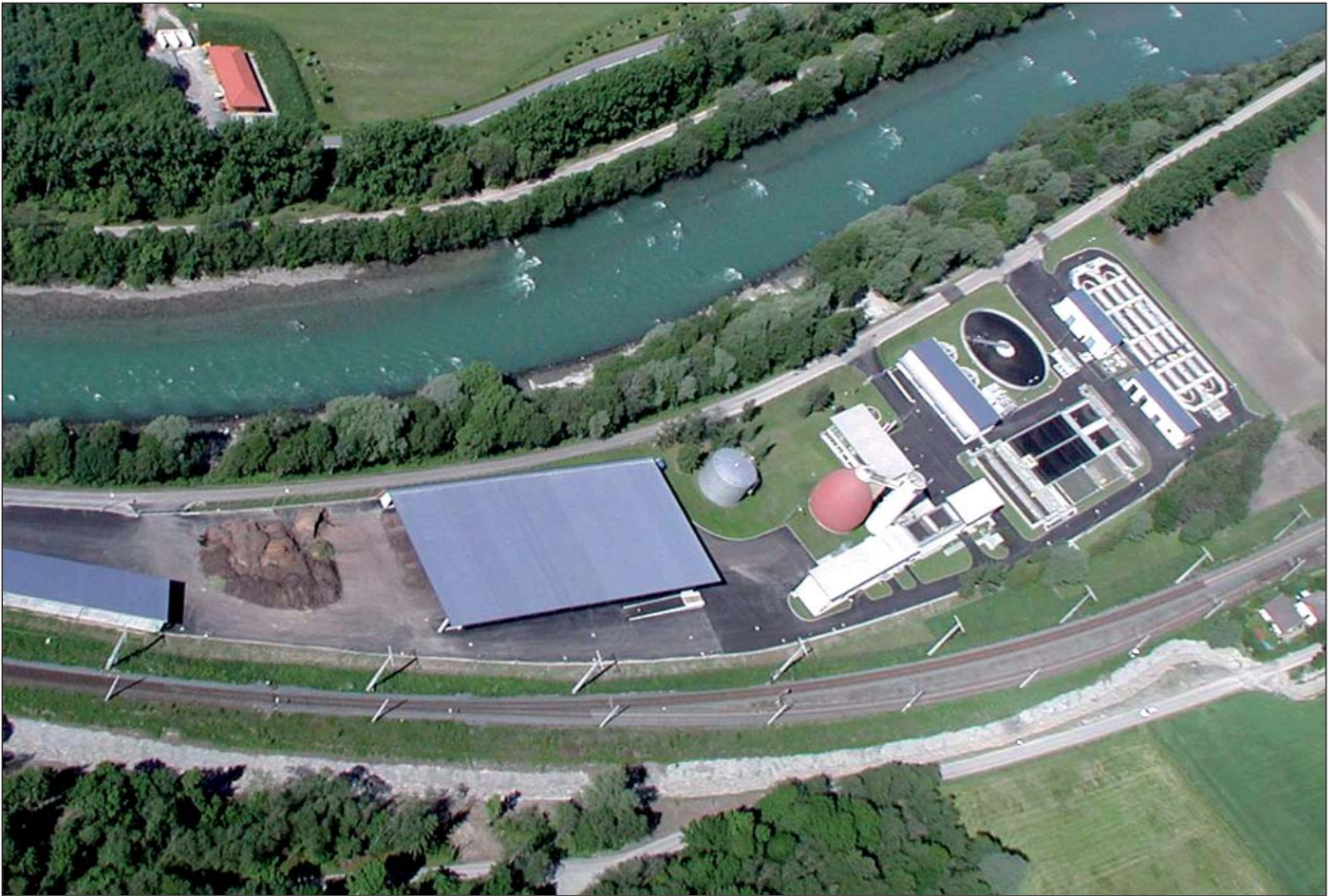
Luftbildaufnahme des Klärwerks in Dölsach
