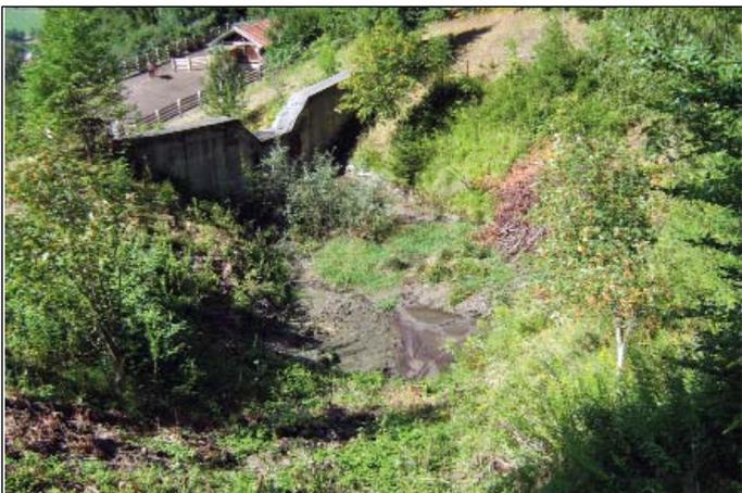
Das Zwieslingbecken wird im Zuge der Verbauung saniert und vergrößert.
