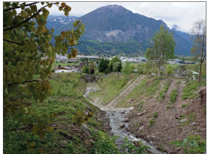
Blick auf ein geräumtes Auffangbecken des Wartschenbachs unterhalb Haus Waldner
